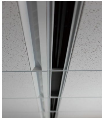
点検口と間接照明の多い病院の廊下にグリッド天井とウォールウォッシャーを組み合わせスッキリ
