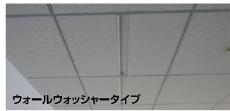
点検口と間接照明の多い病院の廊下にグリッド天井とウォールウォッシャーを組み合わせスッキリ
