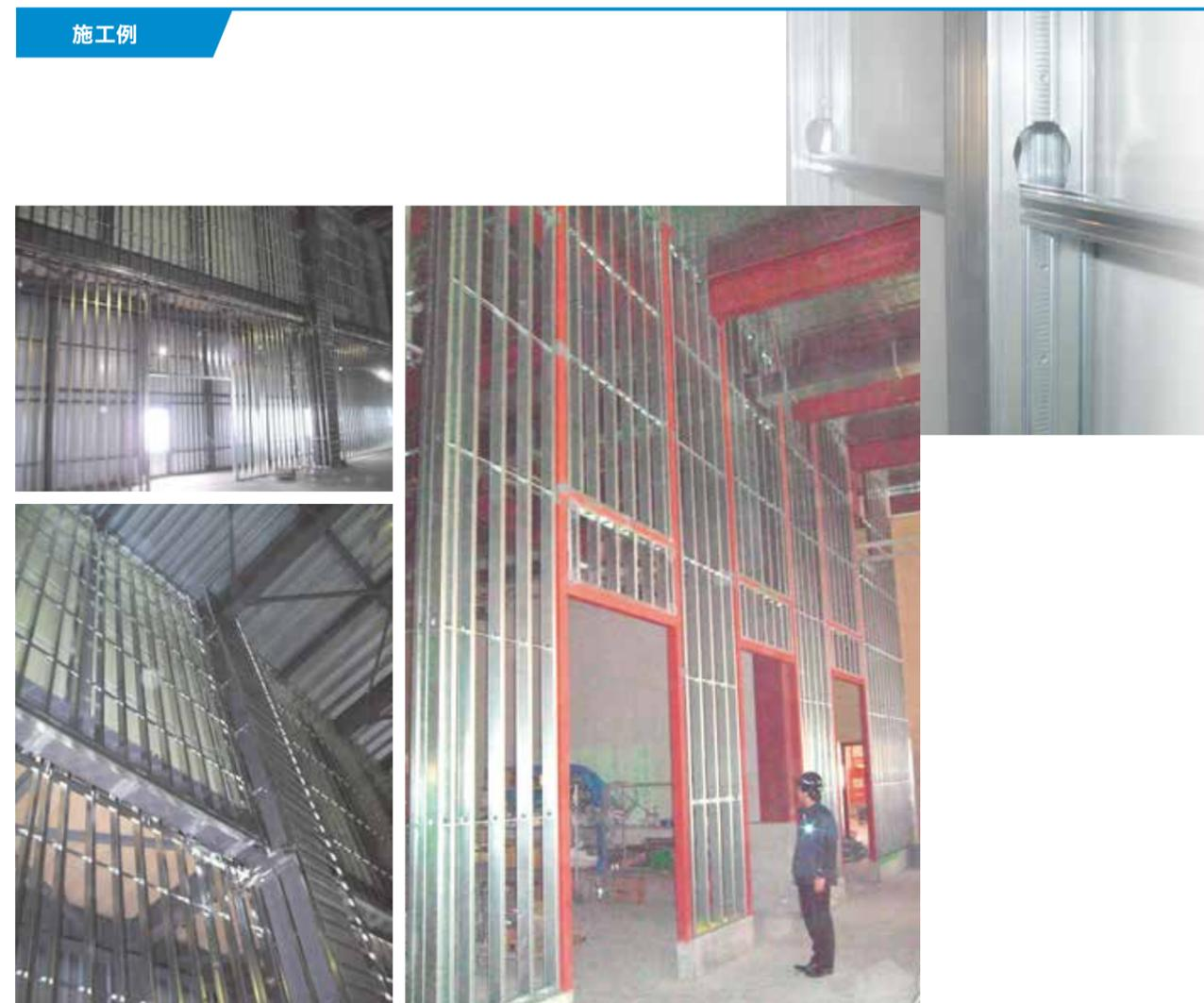
墨出しをする ▶ ランナーを取付ける ▶ SQ-PowerBarを建て込む ▶ 振れ止めを通す ▶ SQ-PowerBarに振れ止めを固定する
