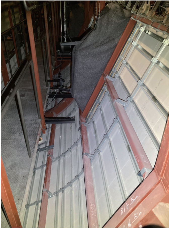
【写真左上・左下】曲面部分の天井下地と施工中の様子 【写真右上】ステージからの急勾配部分の天井下地
