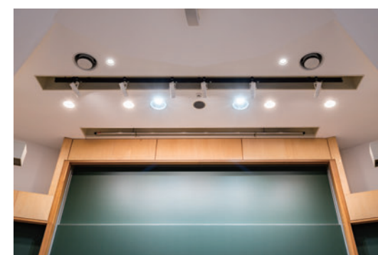
照明開口周辺
