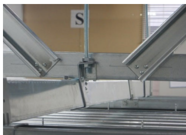
野縁受け・ブレース下部金具の変形
