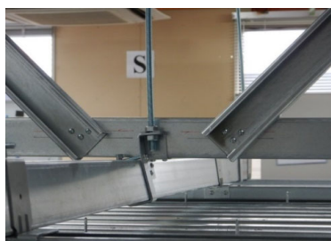
野縁受け・ブレース下部金具の変形
