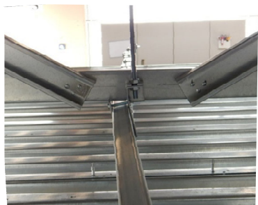
野縁受け・ブレース下部金具の変形
