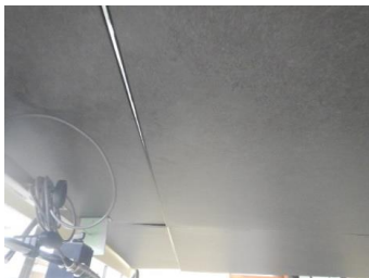
仕上げ材の損傷①
