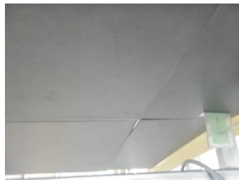
仕上げ材の損傷②
