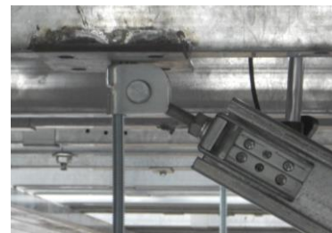
引張側ブレース上部金具の状況
