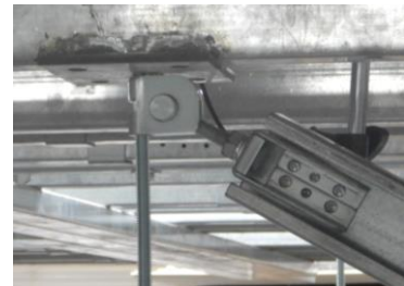
引張側ブレース上部金具の状況
