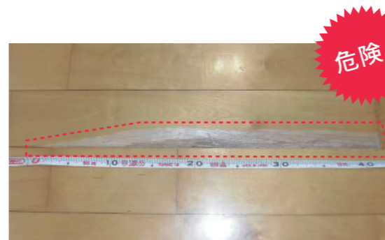
約 40cm にわたり剥がれたささくれ
