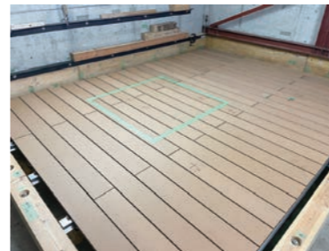
ウッドデッキ材を含めて試験体を施工します。
