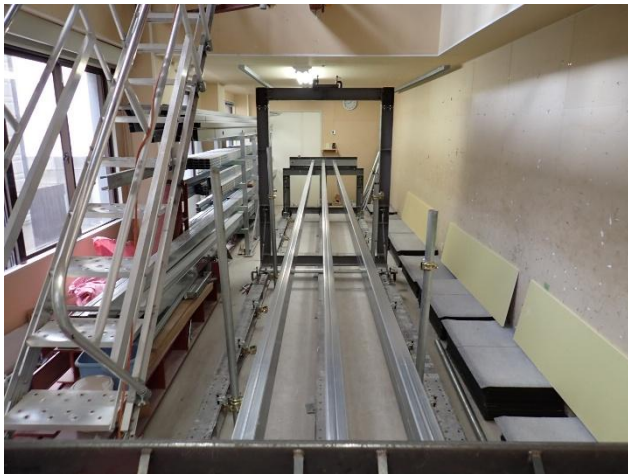
写真 1 試験体施工状況 鋼製下地材全景
