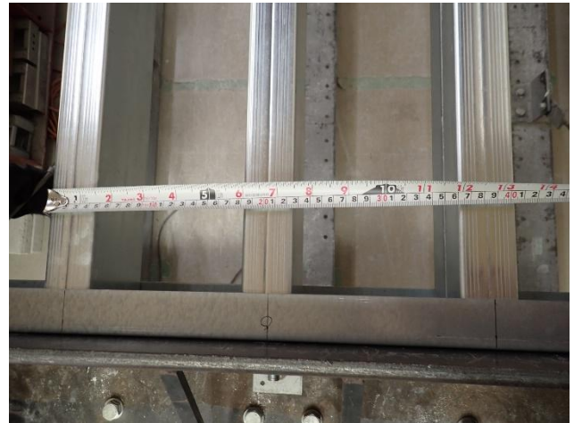
写真 2 試験体施工状況 スタッド間隔 182mm
