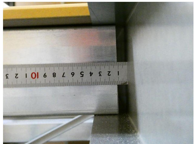
写真 4 試験体施工状況 上部ランナー
