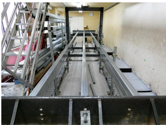
写真 1 試験体施工状況 鋼製下地材全景
