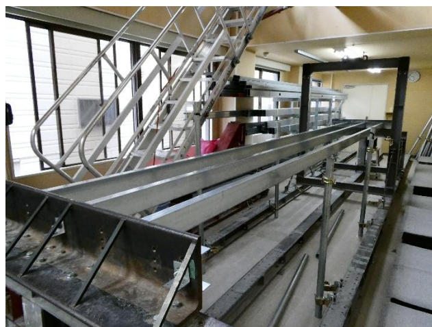
写真 2 試験体施工状況 鋼製下地材全景
