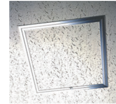
☆☆開口部補強については強度を充分検討して施工願います
