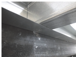
写真4 ビス接合部（裏面）
