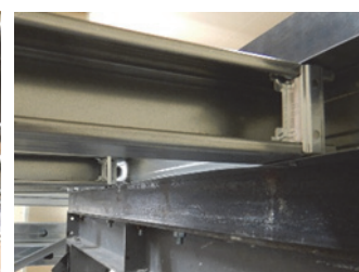
写真7 65形天井側端部
