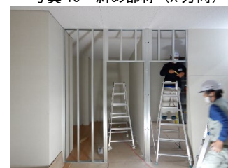
写真 17 角スタッド間仕切り施工状況
