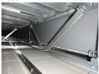
写真 11 斜め部材 (X方向)
