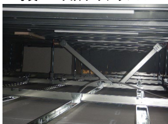
写真 12 斜め部材 (Y方向)
