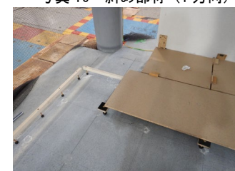
写真 18 乾式二重床施工状況
