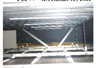
写真 16 斜め部材 (Y方向)
