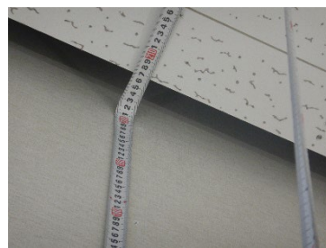
写真 6 天井クリアランス 60mm
