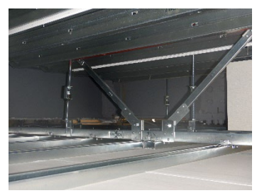
写真 8 斜め部材 (Y 方向)
