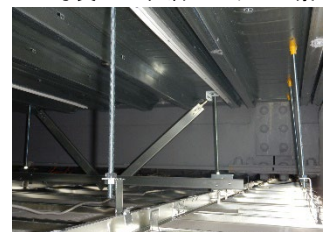
写真 15 斜め部材 (X方向)
