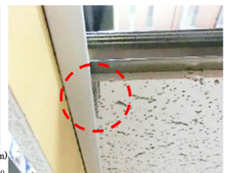
写真4 岩綿と見切り材の接触
