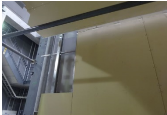
写真 1 局部座屈・仕上げ材脱落
