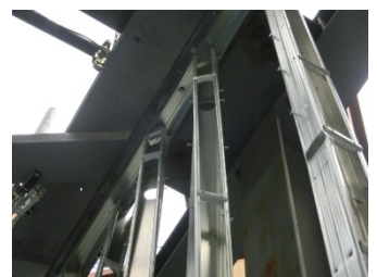
写真 3 上部スタッドの脱落・振れ
