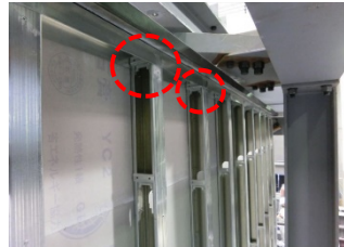
写真 2 フランジ損傷
