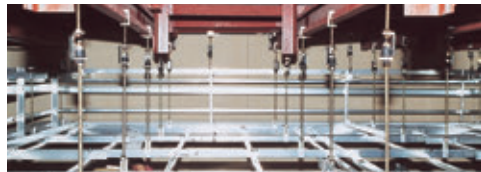
■ 実施工例 (YC-30S)
