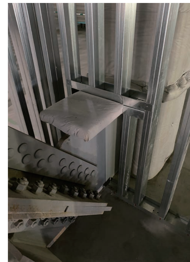
小規模な開口の場合、補強材にはランナー、スタッド同材を用いる。
