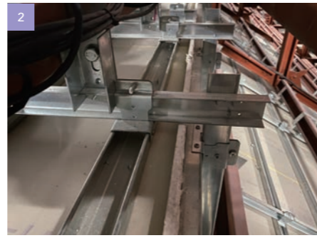
1 準構造耐震天井の段差部納まり例 2 段差に合わせて野縁受けを組み合わせ施工
