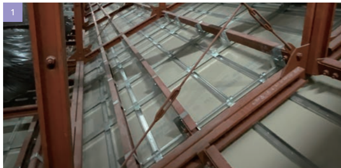
1 支持構造部に沿った天井を構成している 2 角度が異なる天井同士の頂点部分 3 複雑形状の天井を構成することが可能
