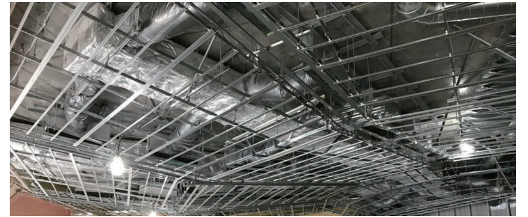
【写真左上】庭園に面する樹形のような意匠の壁 | 【写真右上】折紙形状の天井 | 【写真左下】講堂の壁下地材 | 【写真右下】講堂の天井下地材
