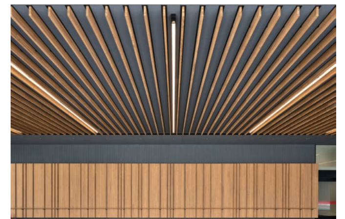
ルーバー端部
