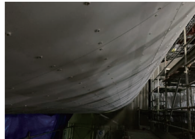
【写真左上・左下】曲面部分の天井下地と施工中の様子 【写真右上】ステージからの急勾配部分の天井下地
