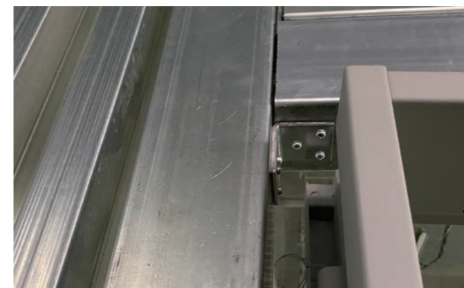
1 壁の開口補強材を金物を用いて固定する
