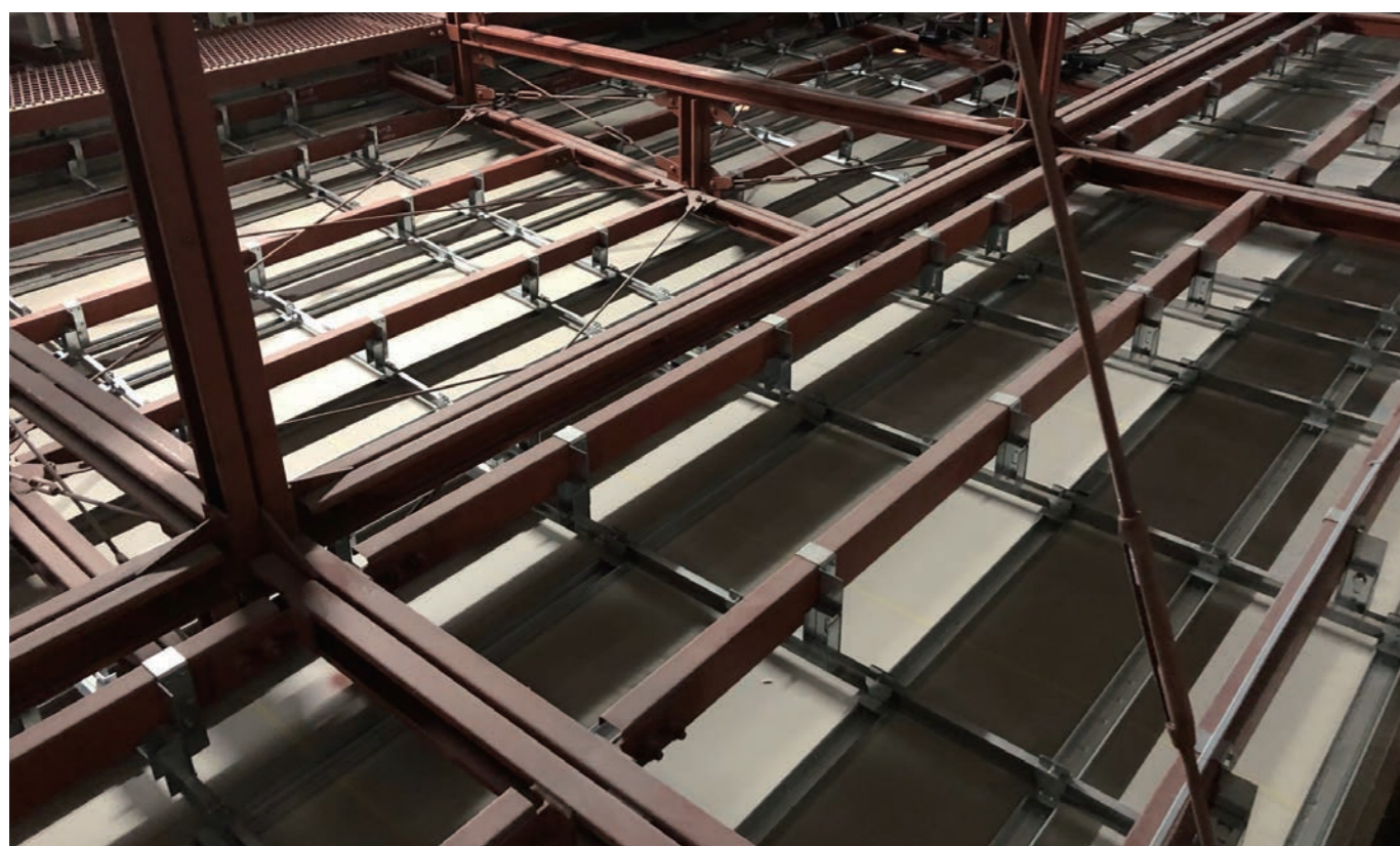
大ホール 天井裏の様子 (KIRII アングルクランプ)
