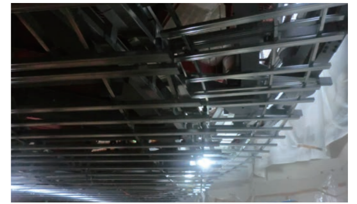
【写真左上・右上・右下】天井内部の下地納まり
