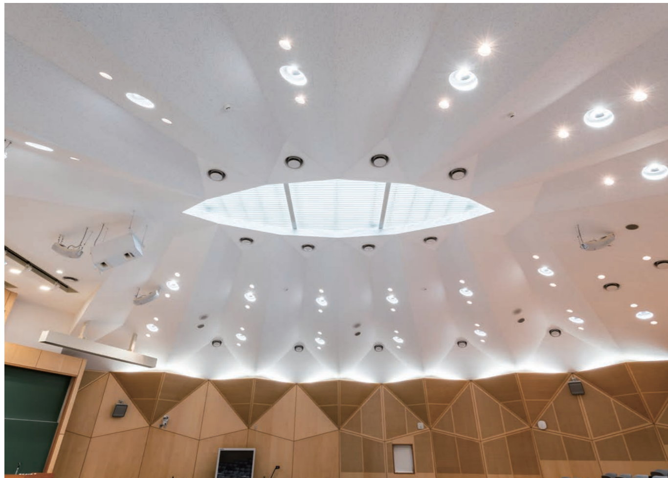
X2通り 天井見上げ
