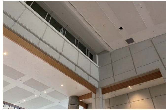
玄関ホール 新耐震 FullPower 天井とアジャストソエルを組合せて使用
