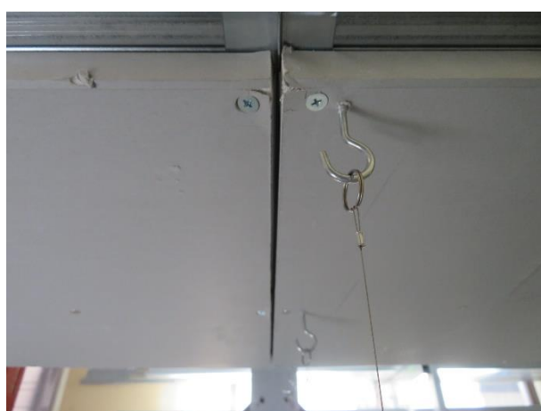
写真10 試験実施状況 中央部目地
