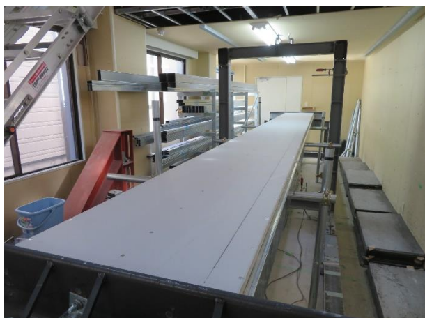
写真 3 試験体施工状況 試験体正面全景
