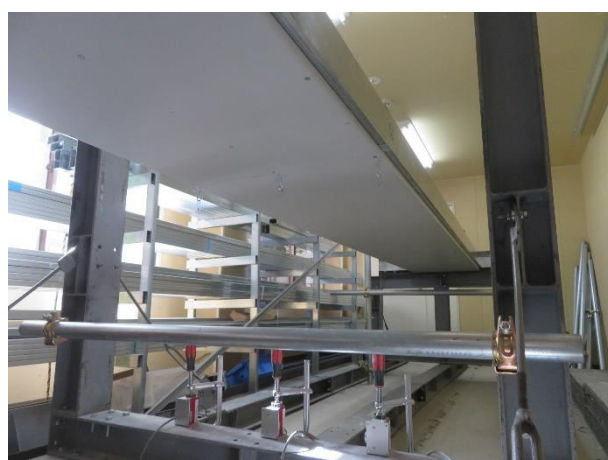
写真 6 試験体施工状況 変位計設置
