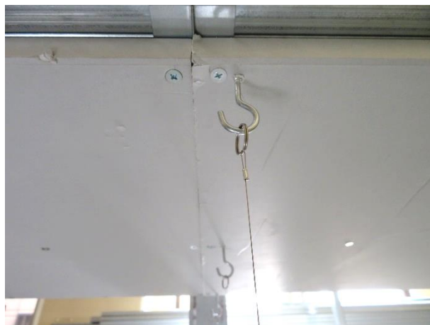
写真8 試験実施前状況 中央部目地
