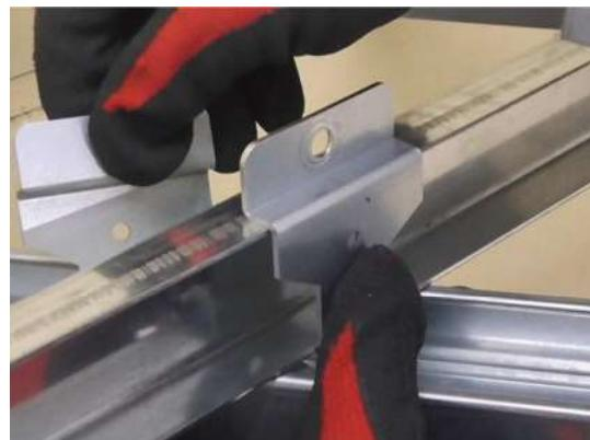
②アプセットボルトを締め込み固定する
