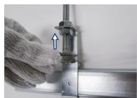
中心の輪を吊りボルトに通し、
