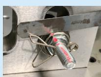
経年などによるハンガーハンガーナットの緩み・落下が確認されています。
