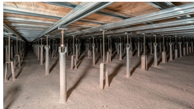
武道場：吹付基礎断熱を施している （通常部：GT フロアー柔剣道場用・補強部：GT フロアーV）
