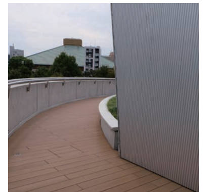
展示室外壁スパンデル部分とウッドデッキの納まり
