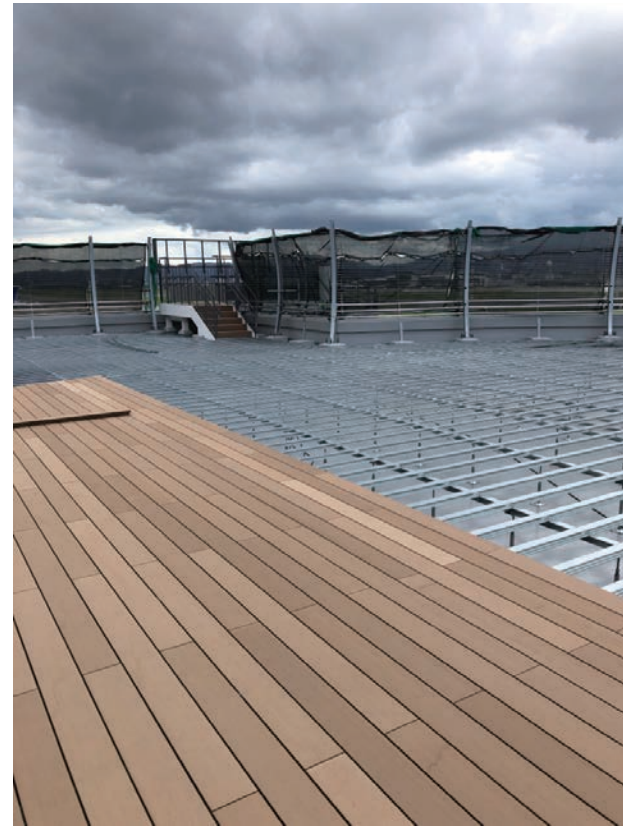
4階 展望デッキの施工中（支持脚・大引・根太まで組みあがった状態）
