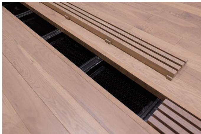
床下空調吹出口の下の鋼材と落下物防止用 SUS メッシュ材は意匠面を考慮し黒に着色
