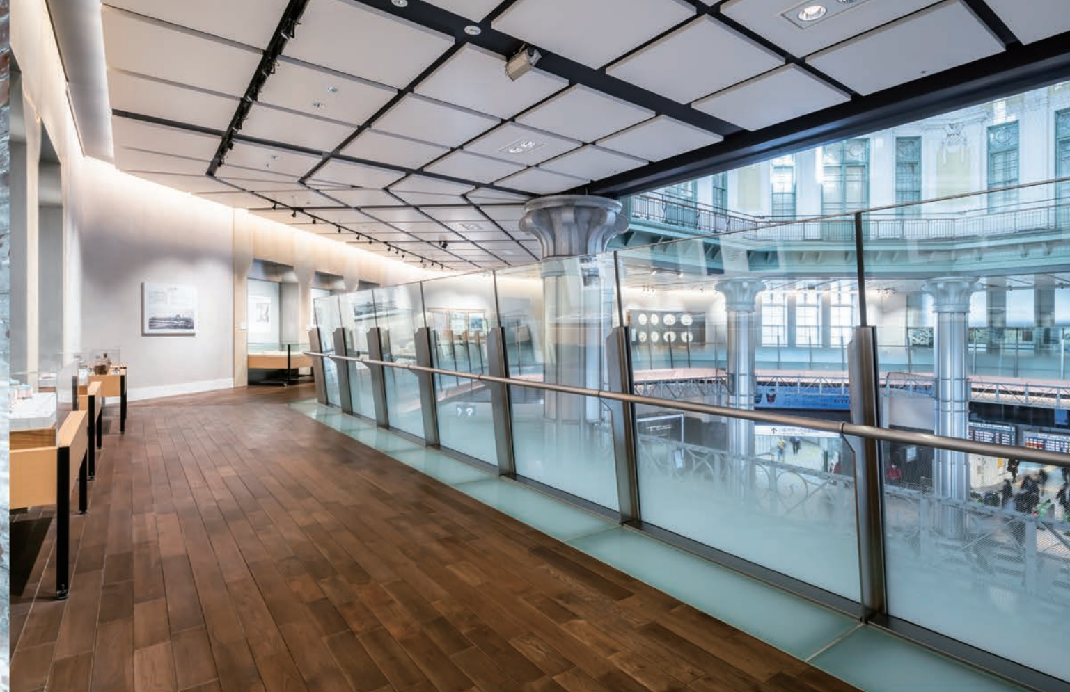
2階ドーム回廊の床はウッドデッキ。手摺側の床は透透性のある仕上材で根太鋼の上に乗っている
