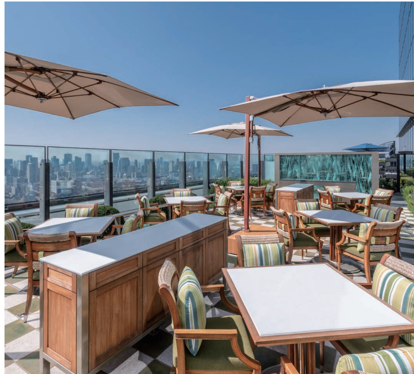
複雑なタイル張りのデザイン、確実な水勾配の確保、工期短縮と下地軽量化が要求されたため、コンクリートやデッキプレートではなく、捨張材に耐水板のKSボードⅡが採用された
