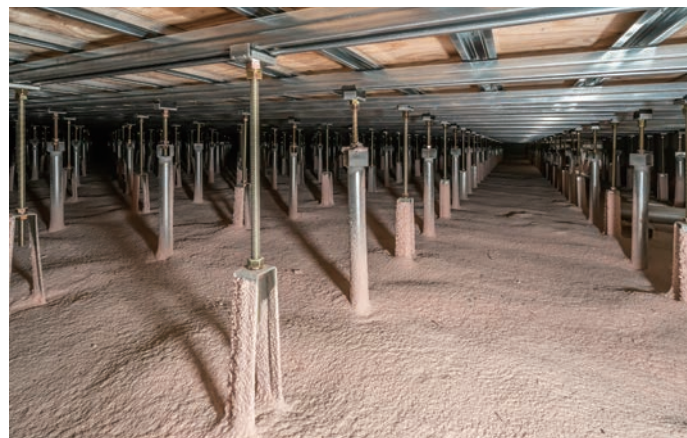
補強支持脚：GT フローVスタンダードタイプを大引鋼の5mm下に設置
