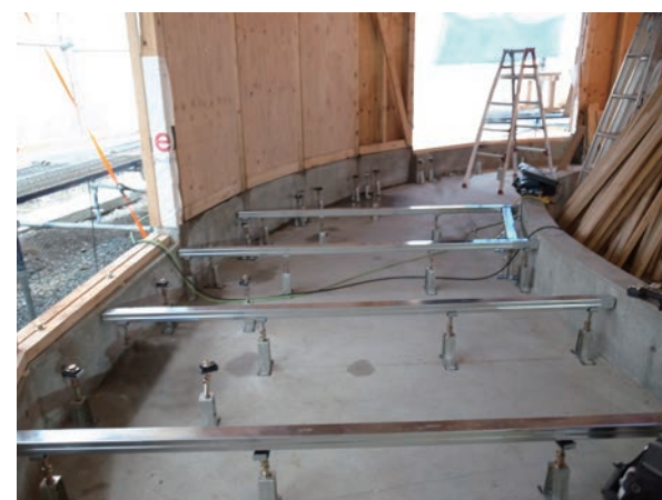
鋼製床 GT フロアースタANDARD支持脚・大引の施工
