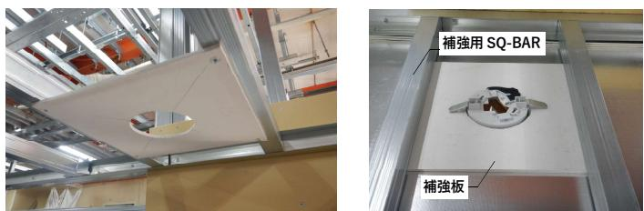
小型設備を取り付ける場合は補強用SQ-BARを2本設置し、タッピングビスで補強板を留付けます。
