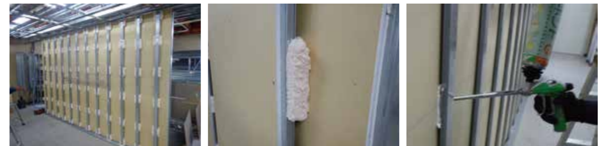
検証のため、石膏ボードの上に施工を行っています。実際の現場では仕様が異なります。
