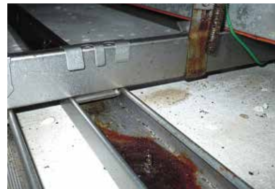
錆びた天井下地の例。劣化すると、強風や地震の揺れをきっかけに天井全体が崩落する恐れがある
