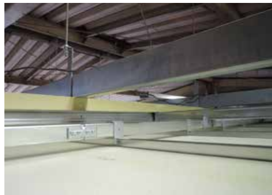
最小130mmの高さで施工可能
