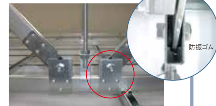
ブレース下側の金具に防振ゴムを使用
