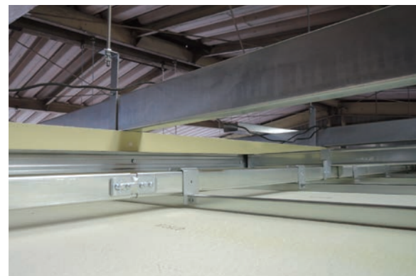
吊りボルト・ブレース不要、最少130mmの高さで施工可能
