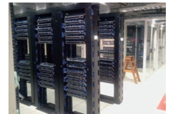
避難経路、サーバールーム等
