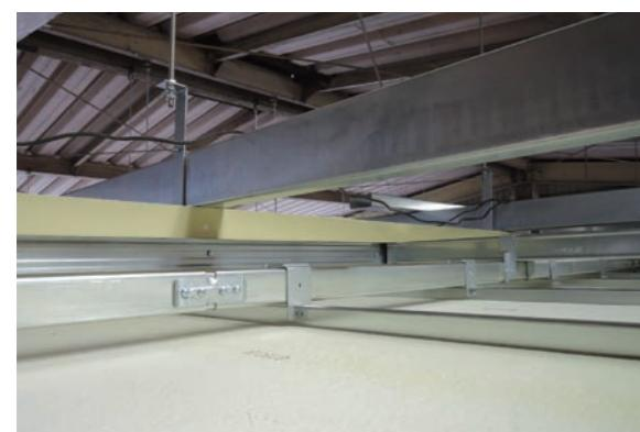
吊りボルト・プレース不要、最小130mmの高さで施工可能
