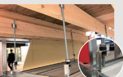
木梁に鋼製の吊り天井を組み合わせた例です。ハンガー下側に「インスタントロック」を取り付けることで、地震や経年によるナットのゆるみを抑え、天井の脱落を防止します。
