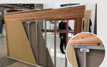
ランナーとスタッドの2部材のみで下地を構成できる「SQ工法」です。同じ部材で天井下地も構築できるため、スピーディかつ正確な施工を可能にします。木材のような収縮が起きないため、施工後も長く美しい仕上がり面を維持できます。
