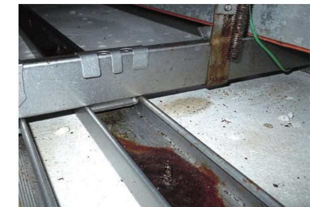
錆びた天井下地の例。劣化すると、強風や地震の揺れをきっかけに天井全体が崩落する恐れがある
