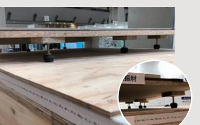
パリアレスフロアは支持脚に取り付けられた防振ゴムにより、高い強度と遮音性を備えた床下地工法です。アスファルト系制振材やユカテック (旭化成建材) を付加することで、より遮音性を高めることができます。
