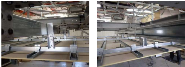
写真 3 最大荷重時状況（3 構面部分モデル試験）
