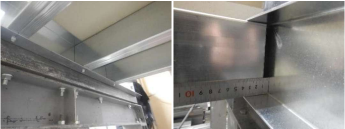
写真 3 下部ランナービス固定部 写真 4 上部ランナークリアランス部
